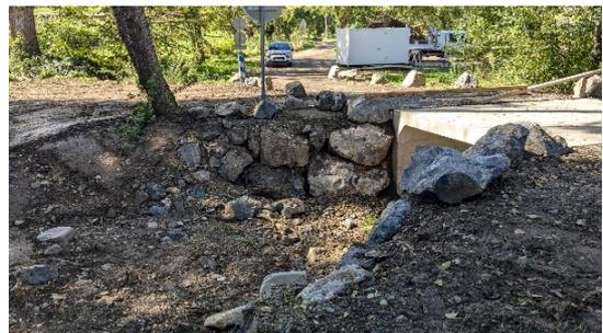
Concernant la consolidation, 2 mètres d'enrochement et une grande quantité de béton ont été indispensables au renforcement de la structure des 2 côtés. Chaque pilier faisant face au flux a été renforcé d'une pièce métallique angulée remplie de béton, afin d'éviter l'empilage des hypothétiques troncs et branchages.
